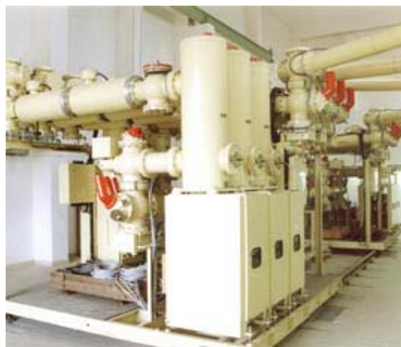
Obr. 1 Príklad zapuzdreného rozvádzača 123 kV s izoláciou SF 6
